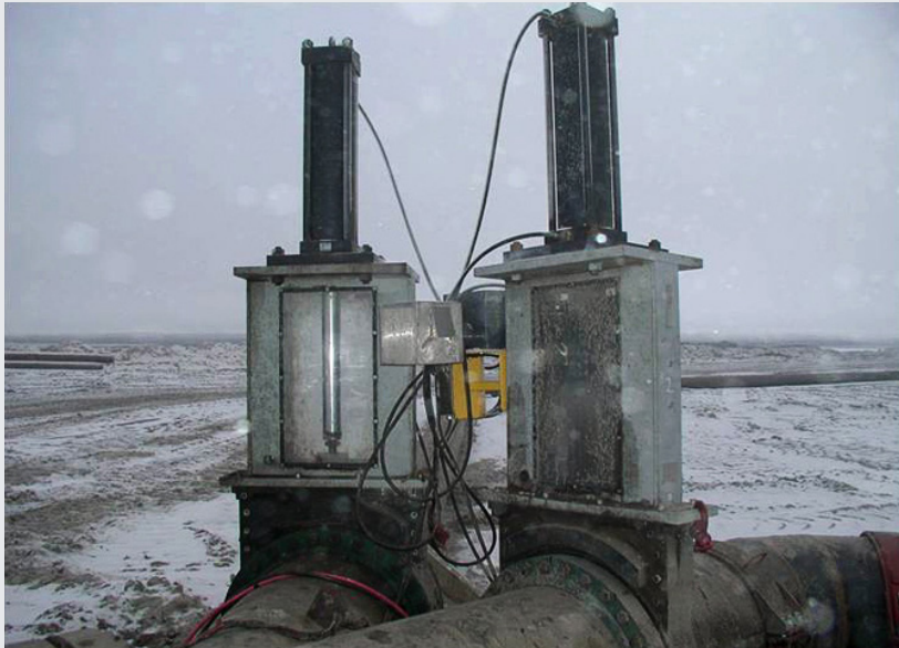
Modèle ML, alésage de 8", avec joints pour températures basses
