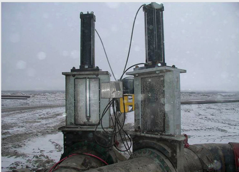
Serie ML de 8" de diámetro con sellos de baja temperatura
